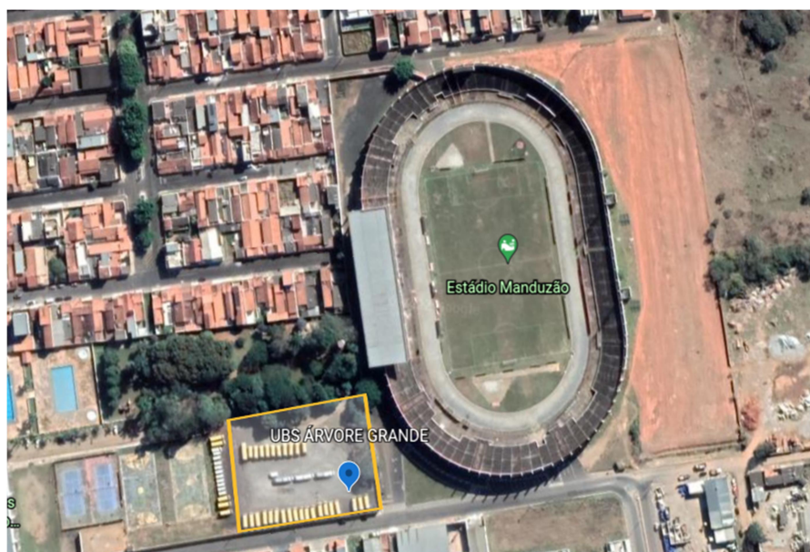
Figura 1: Local de Construção UBS Árvore Grande
